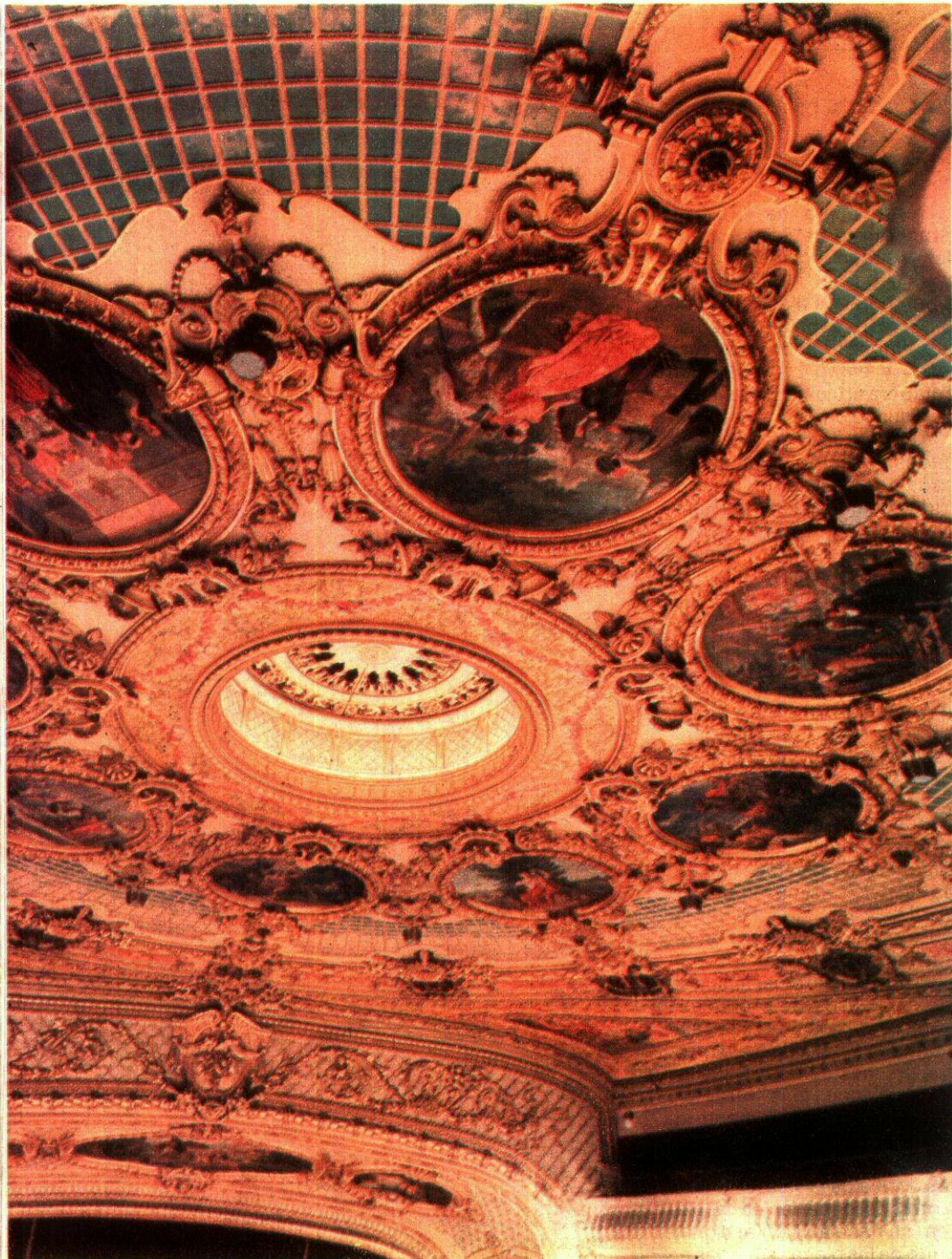
Los fondos del cielo raso con las molduras de 1883 en torno a las pinturas de 1861
